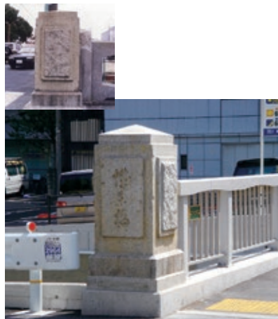
親柱の移設・再利用
