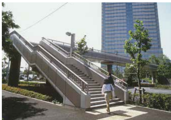
豊洲ONビル歩道橋
