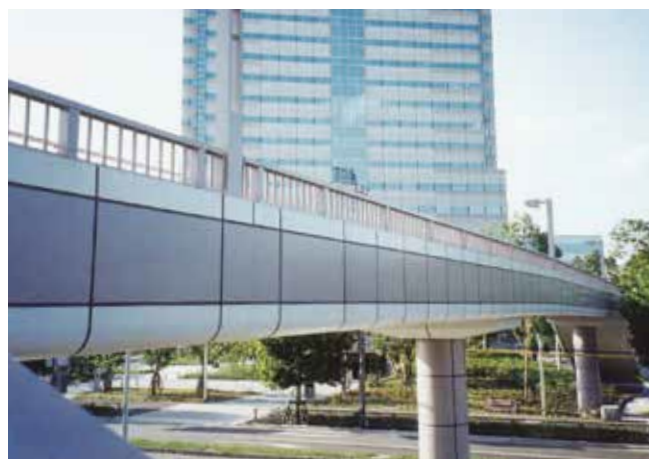
豊洲ONビル歩道橋
