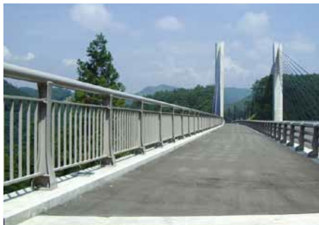
築川ダム9号橋
