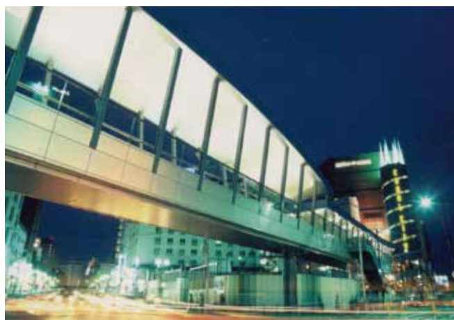
市道祇園住吉線歩道橋
