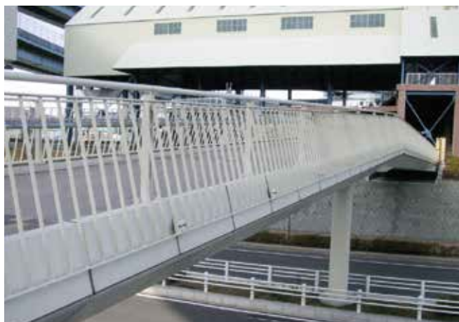
東田第一高炉前歩道橋
