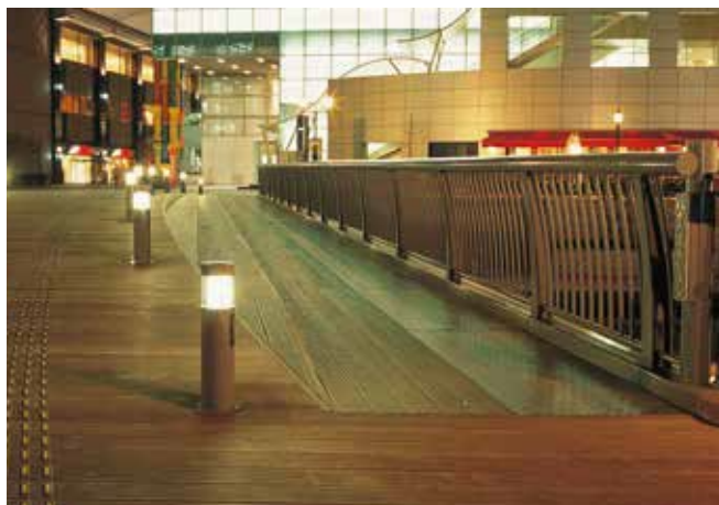
博多ことぶき橋
