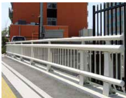
市道箱崎146号線歩道橋
