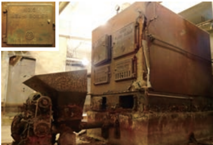
地下室に残る自動給炭器付きアサヒボイラー5型。1936年10月製造の銘板が貼付されています。
