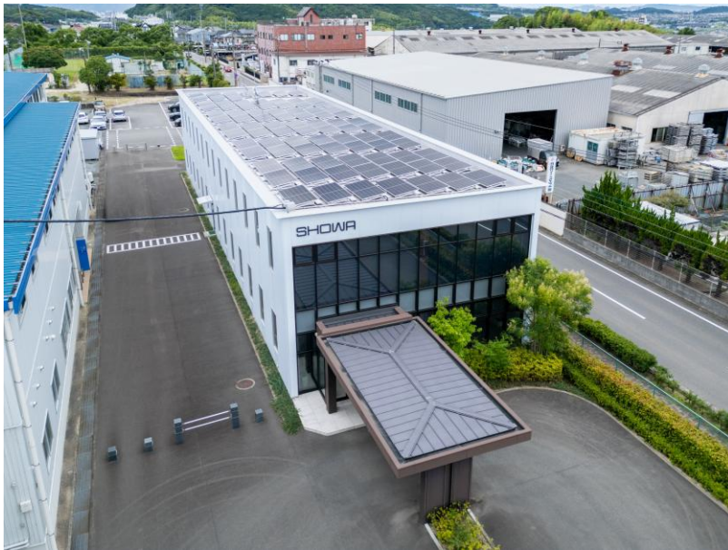
宇美工場（本社棟） 最大出力50kW
