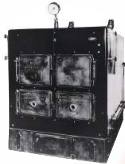
初の国産鑄鉄製ボイラーの一つと数えられるストレーベルボイラー。(大正期)
