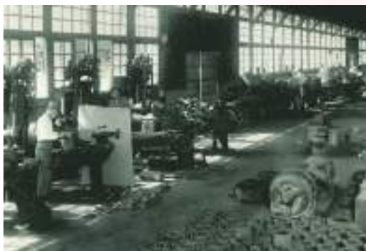
昭和初期の当社鑄鉄工場。ボイラー、バーナー、ラジエーター等を製造していた。手前に見えるのはバーナーの部品。
