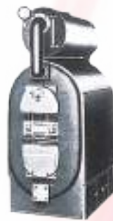
初の国産鑄鉄製ボイラーの一つと数えられるストレーベルボイラー。(大正期)
